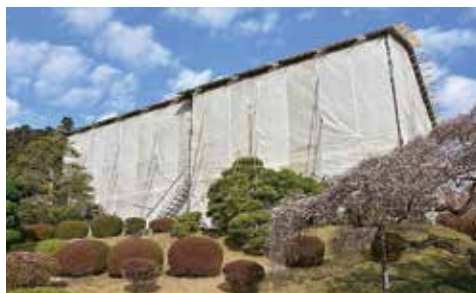
工事中の貴賓館
