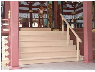
左右宮拝殿に設置の手すり
