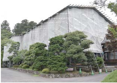
葺替中の社務所
