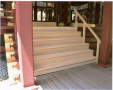
別宮拝殿に設置の手すり
