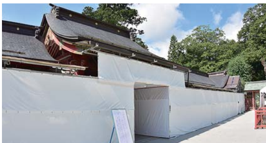
工事中の門と東西廻廊
